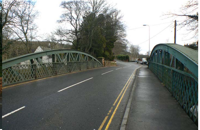
Bridge of Lednock
