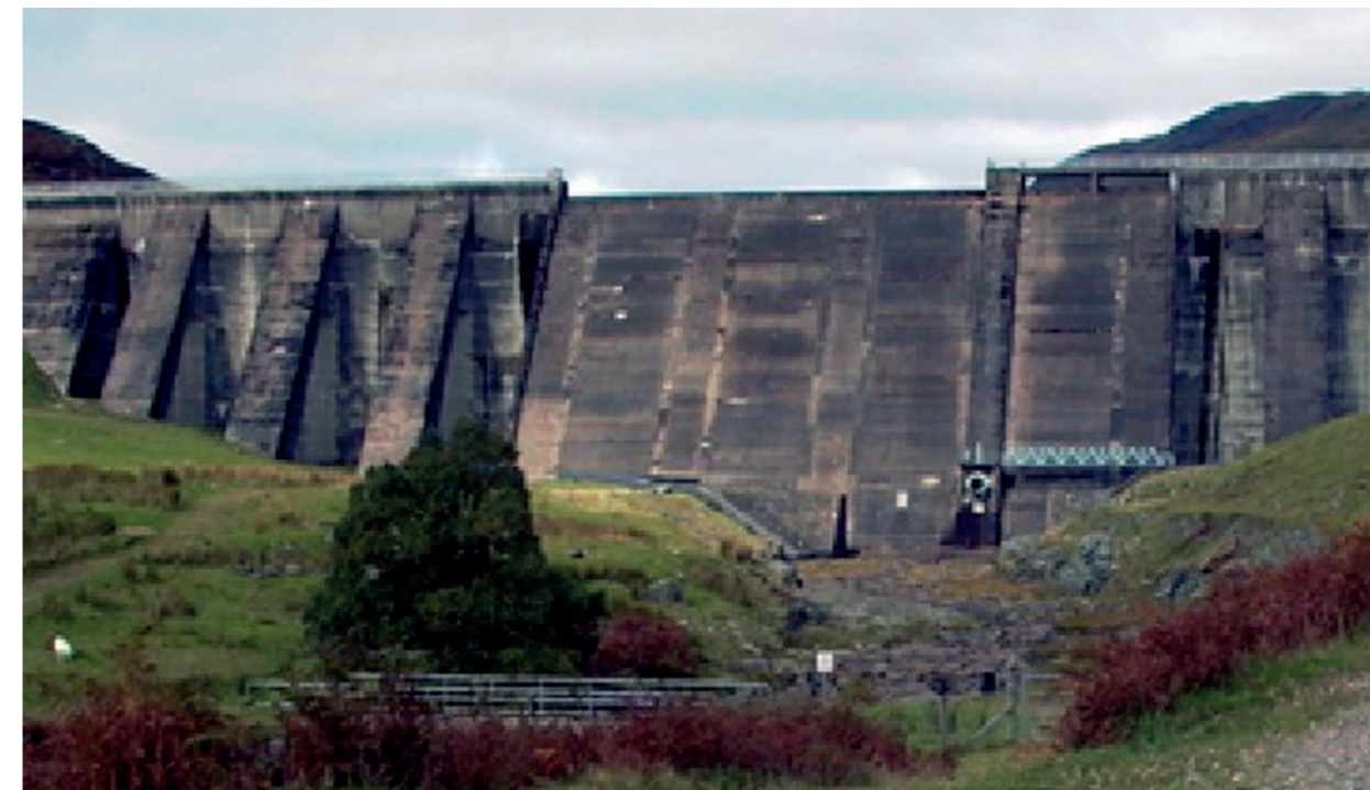
Figure 21: Lednock Dam, Glen Lednock.
