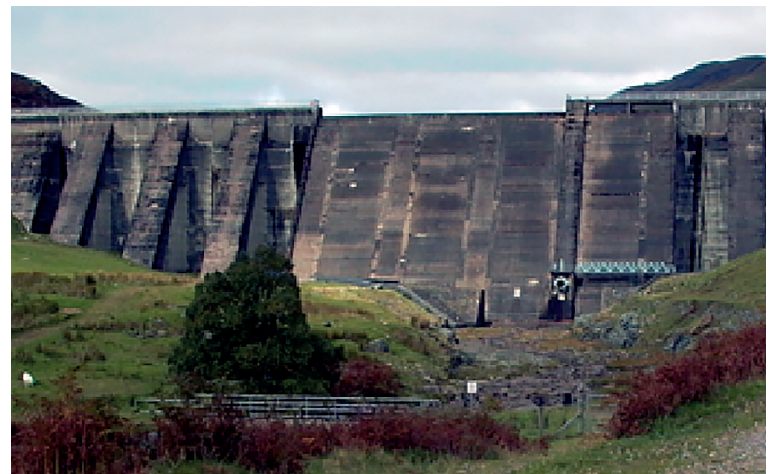
Figure 6: Lednock Dam, Glen Lednock.
